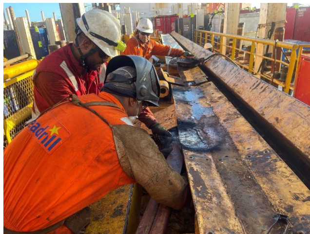
Figura 2 — Equipe da LMI realizando inspeção detalhada e trabalhos no de mecânicos conjunto trilhos do Catwalk de Tubos
