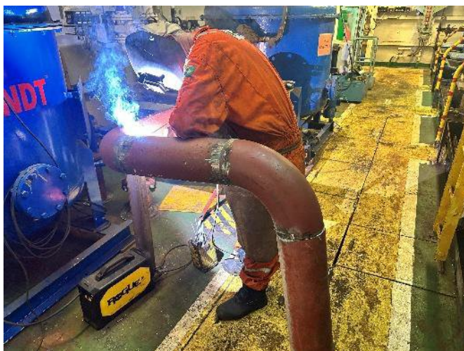
Figura 10 — Soldador da LMI realizando modificacao de tubulacao e de nas trabalhos conexao linhas de succao e descarga do degaseificador
