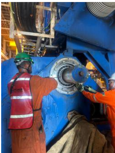
Figura 5 — Técnicos da LMI realizando desmontagem e remoção de na do a rolamento extremidade virabrequim durante revisão
