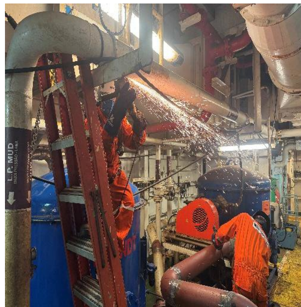
Figura 11 — Tecnicos da LMI realizando operacoes de corte e no sistema de esmerilhamento tubulacao do degaseificador
